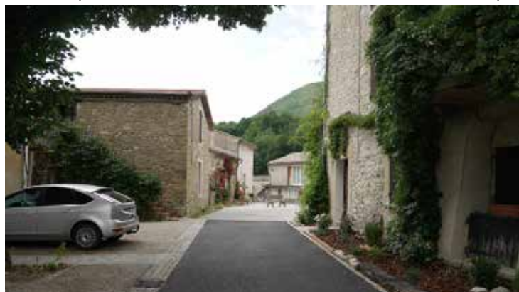
Dans cette rue en zone de rencontre, les riverains disposent de seuils et d'espaces de plantation en limite de propriété si bien que la chaussée ne s'étend pas totalement de façade à façade et est un peu plus resserrée.
