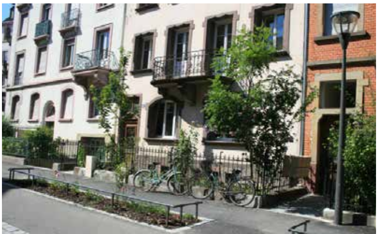
Dans ce quartier de faubourg, une cour de devant privative permet d'installer un seuil, des marches, des boîtes aux lettres, des plantations, et lorsque les immeubles disposent d'une cave, de créer un accès direct, une ventilation et un éclairage naturels à celle-ci.
