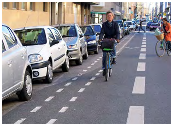
Bande cyclable avec mise en place d'un espace de sécurité entre le stationnement et l'aménagement cyclable
